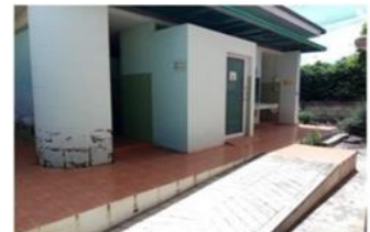
ห้องน้ำสาธารณะสะอาดเพื่อบริการประชาชน ณ ศูนย์บริการประชาชนตำบลหาดเสี้ยว
